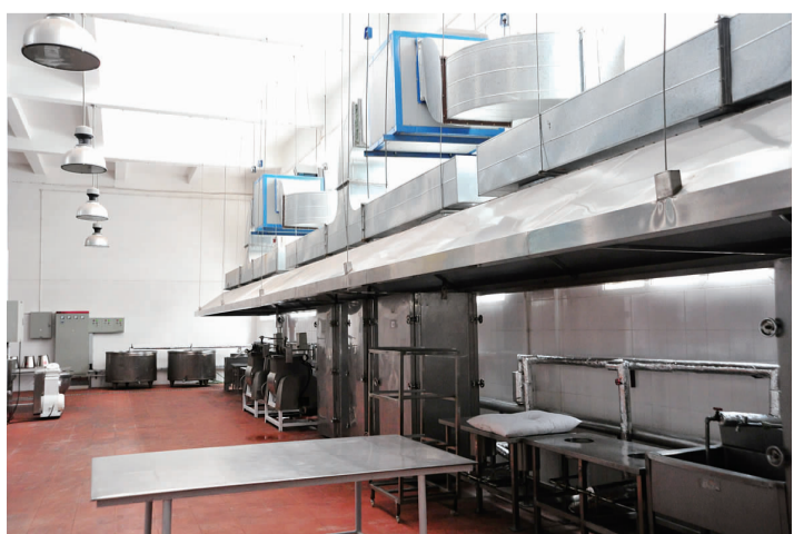
经过整改后的南市乔家栅食品厂生产现场
