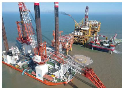
装团队和驾驶台操作人员紧密配合，调整船向、跟踪调载，在浪峰与浪谷的间隙中争分夺秒，抓住风浪间隙的短暂平稳期迅速起吊、调整、对接，最终在“群力”轮施工团队的完美配合下一次次顺利完成安装更换。
