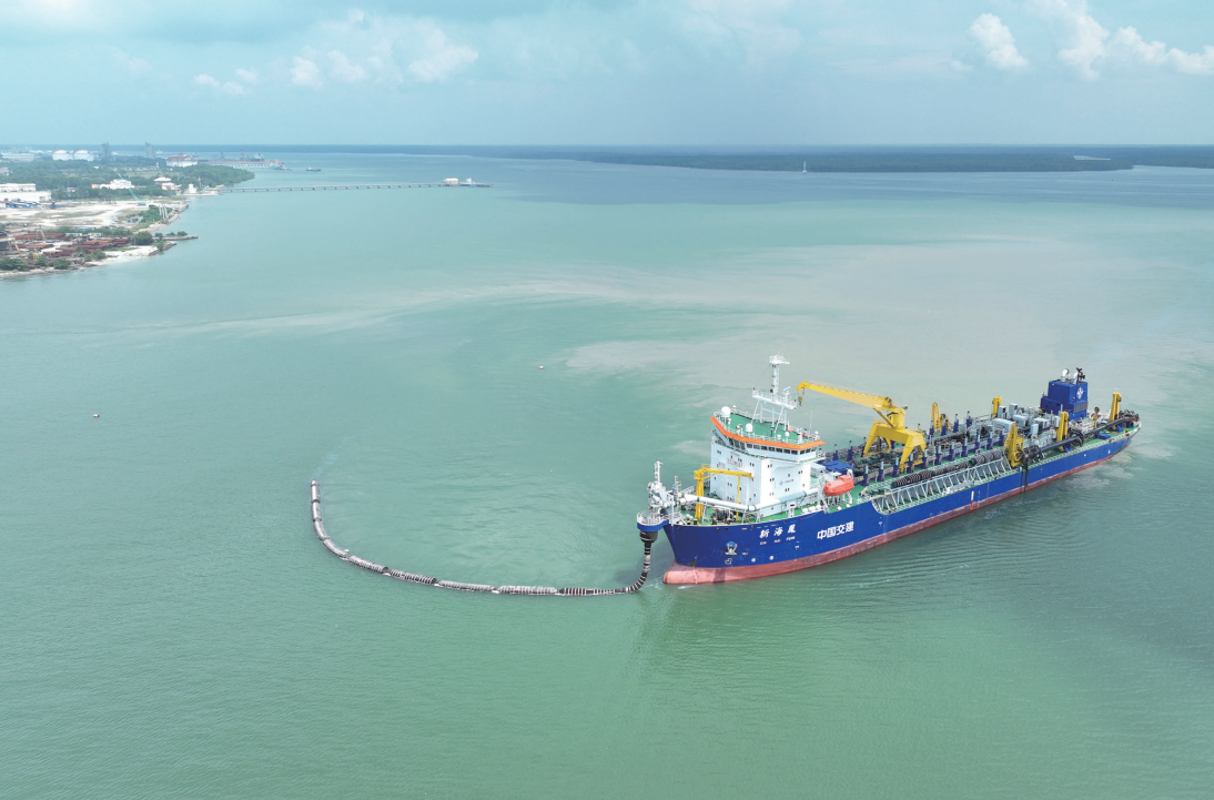
本报讯 近日，由公司参建的马来西亚吹填项目正式开工。项目建成后，将进一步提升马来西亚基础设施水平，为实现陆海联运提供坚实的基础保障，为地区经济发展贡献中交力量。（陶瑞强/文 蓝菁/供图）
