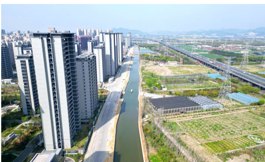
本报讯 4月4日,由中交水利公司承建的浙江宁波镇海区董家畝区块配套基础设施工程东升新河河道开挖工程完成并通水,极大提升了水体自净能力与区域防洪标准。(马阿牛 文/供图)
