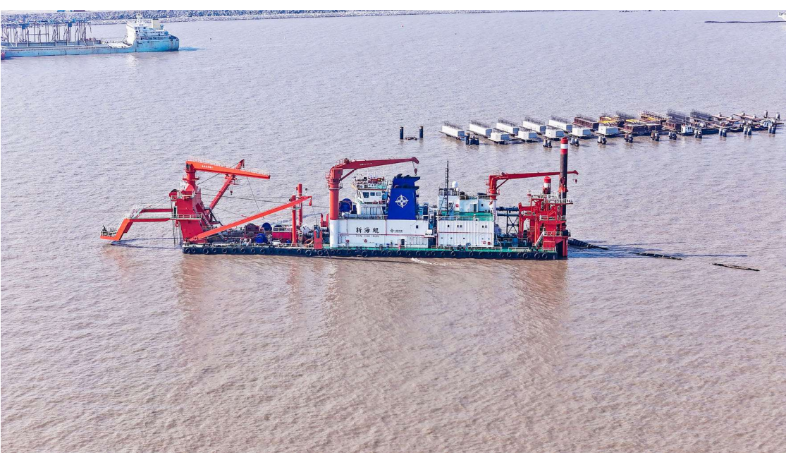
本报讯 近日,由公司承建的江苏南通港小庙洪上延航道工程掀起施工热潮。项目部始终紧扣航道建设总体目标,以科学规划为引领,实施精细化管理,并先后投入“新海鲲”轮、“新海鲤”轮等多艘疏浚船舶,全力保障航道通航与工程施工两不误。(单良 文/供图)
