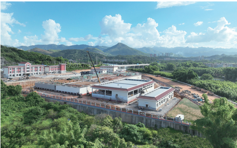
本报讯 近日,由福建交建公司承建的福建漳州云霄县中心城区污水处理提质增效工程项目的污水处理厂建设工程,设备安装工程已顺利完成。(刘光辉 文/供图)
