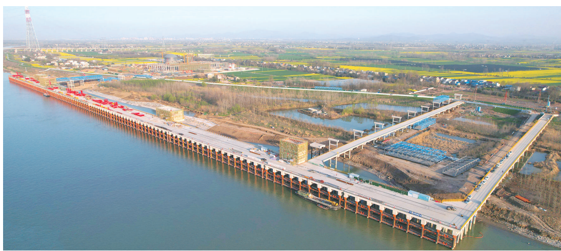
本报讯 截至目前,江苏交建公司安徽池州港乌沙港区公用码头工程(水域部分)项目整体进度已完成约90%,码头工程主体结构与房建工程主体结构已全部完成施工。(周占册 文/供图)
