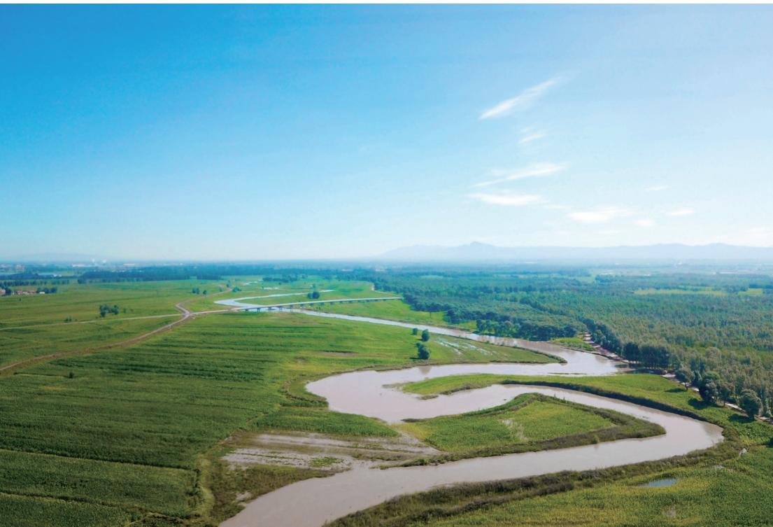
本报讯 近日,公司承建的山西朔州桑干河应县段河道综合治理工程主体工程完工。项目建成后,将有效提高堤防防洪等级,改善河道生态环境,实现水清、河畅、岸绿的生态目标。(程昕/文 梁政/供图)
