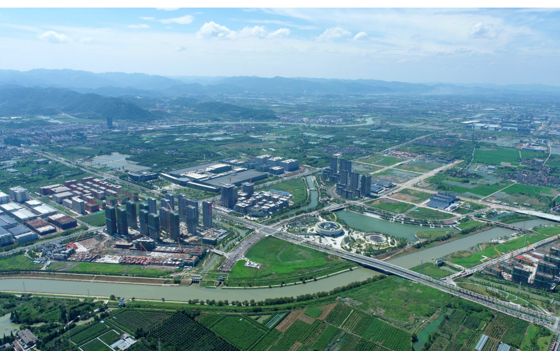
本报讯 公司承建的宁波奉化滨江生态公园项目(一期)工程是宁波市奉化区“二山三网四心五廊”的生态景观中至关重要的生态廊道之一,将有效提升奉化城市转型示范区生态环境,塑造良好城市形象。(黎皓 文/供图)
