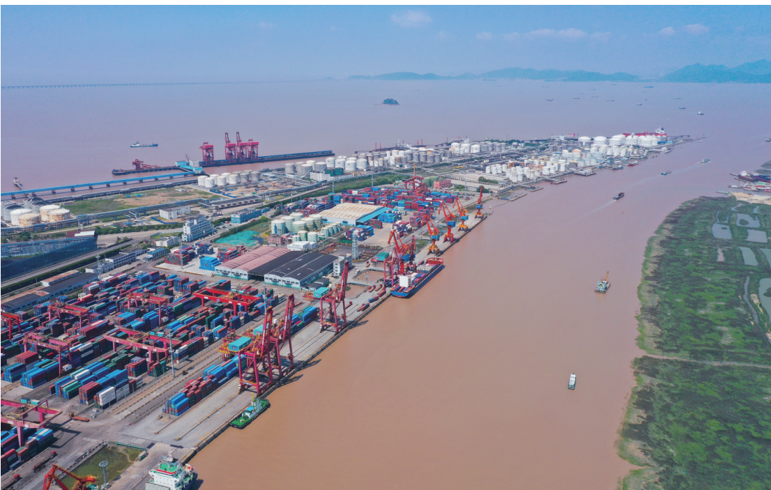
本报讯 5月11日，公司承建的宁波舟山港镇海港区21#-22#泊位调头区临时疏浚工程完工。临时疏浚完工后，有效提高了镇海港区的通航率，进一步增强了镇海港区作为多功能、综合性港区的实力。(梁政 文/供图)
