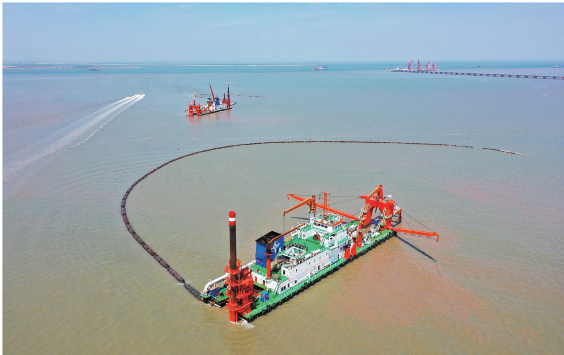
收。工程建成后将进一步完善南通通州湾长江集装箱运输新出海通道。服务长三角区域一体化发展战略。(聂明磊 文供图)
