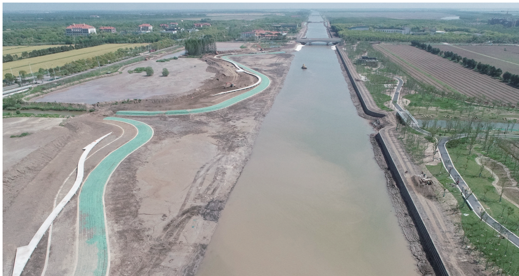
团旺河道疏浚和护岸结构工程。河道疏浚和护岸结构工程。
